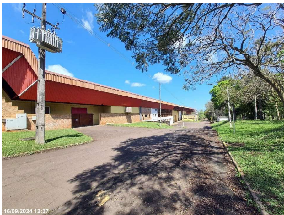
Figura 3: Área de Fundo - Centro de Convenções de Foz do Iguaçu
