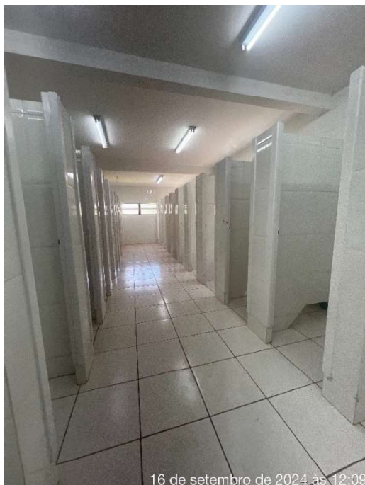
Figura 17: Pavilhão Cataratas - Boxes Sanitário Feminino anexo
