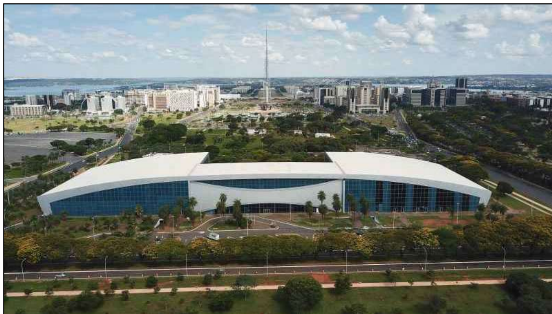
Figura 104: Vista panorâmica do Centro de Convenções Ulysses Guimarães
