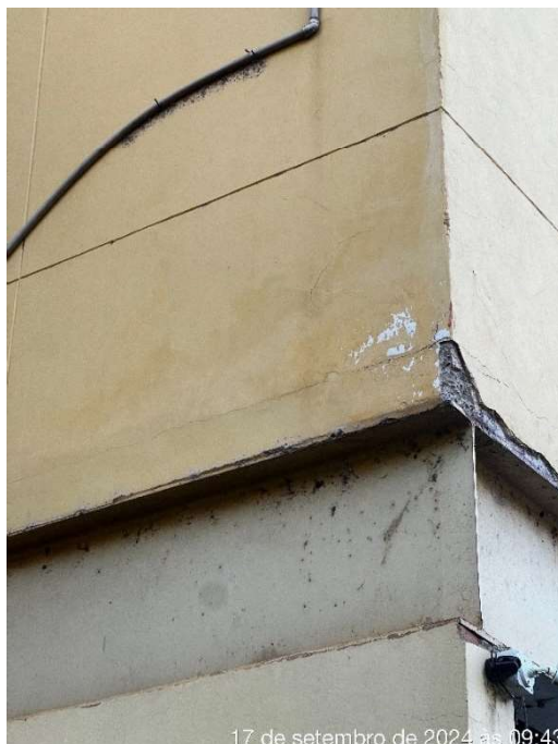
Figura 89: Fachada - Encontro alvenarias e vigas metálicas
