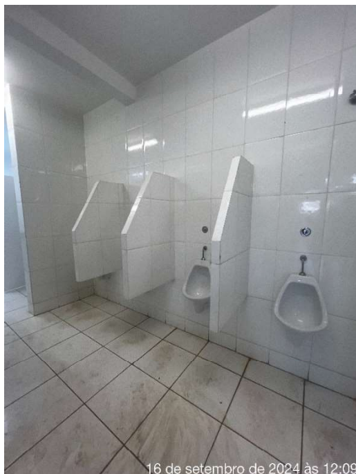
Figura 21: Pavilhão Cataratas - Sanitário Masculino anexo
