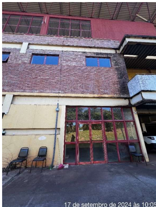
Figura 90: Detalhe Fachada da área de Estacionamento
