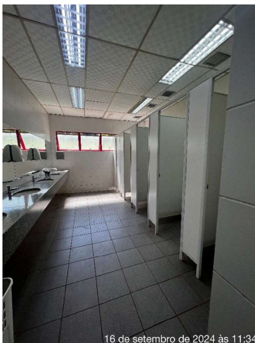
Figura 47: Bancada Sanitário Masculino Salão Itaipu
