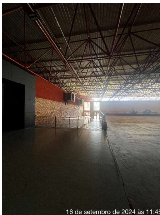
Figura 83: Rampa interna - Acesso Pavilhão
