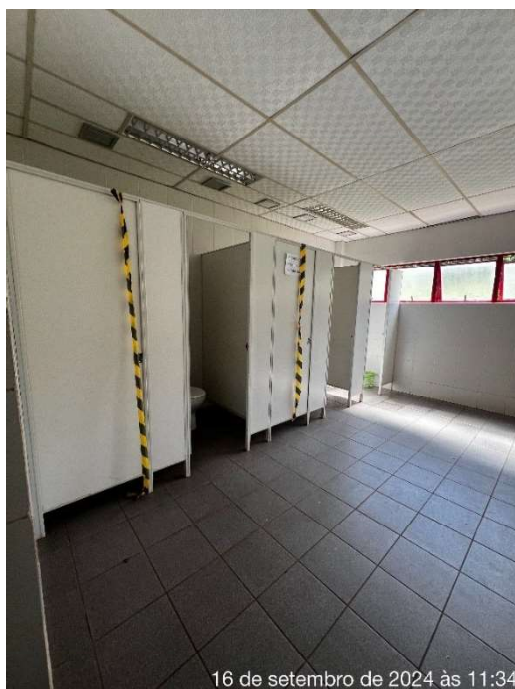
Figura 45: Sanitário Feminino Salão Itaipu
