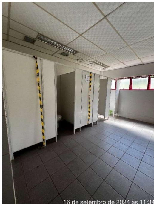
Figura 100: Sanitário do Salão Itaipu
