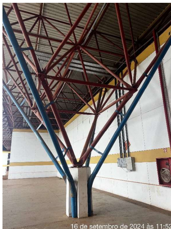
Figura 6: Pilar de concreto armado e estrutura metálica da cobertura
