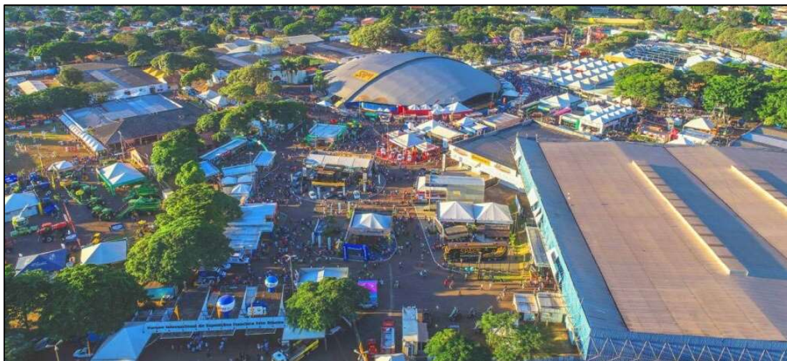
Figura 103: Parque Internacional de Exposições de Maringá durante a Expoingá
