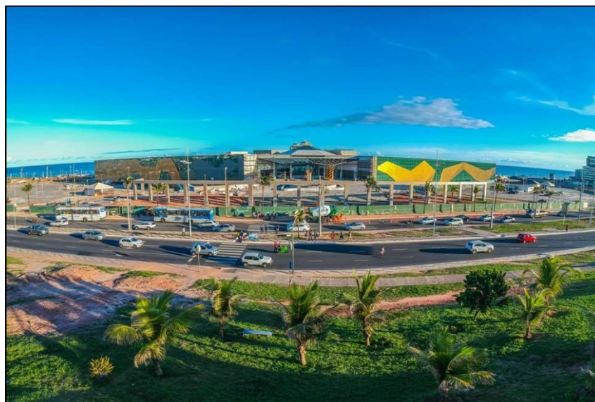
Figura 105: Imagem frontal do Centro de Convenções de Salvador
