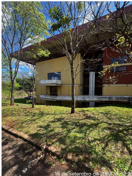
Figura 82: Rampa externa - Acesso estacionamento
