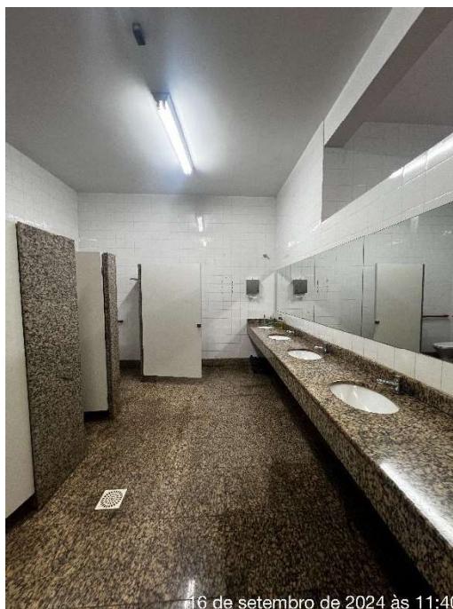
Figura 27: Sanitário Feminino - Bancada
