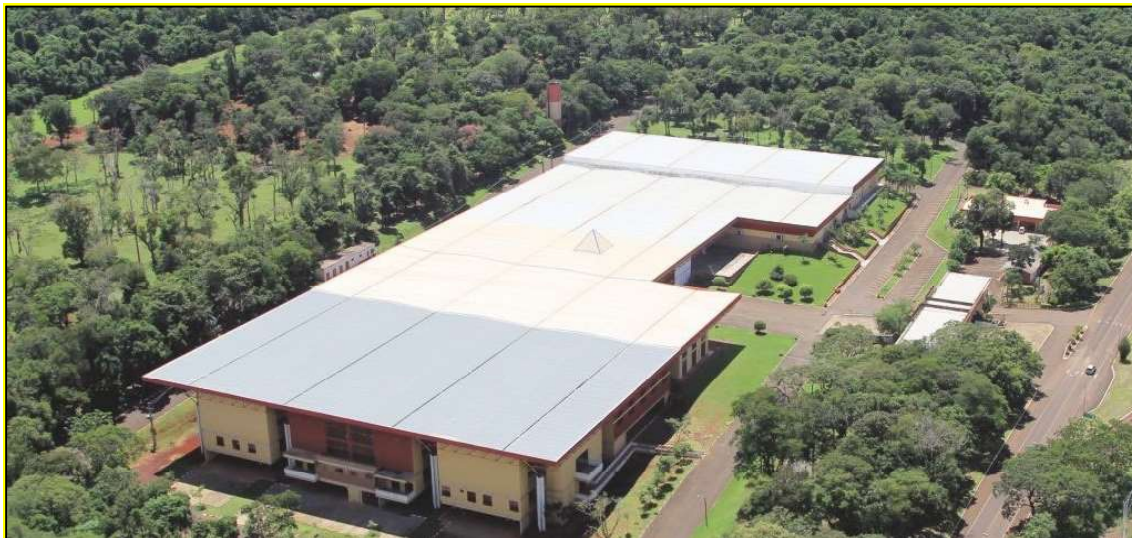
Figura 7: Cobertura Centro de Convenções de Foz do Iguaçu
