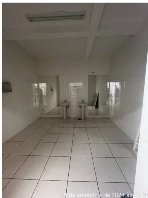
Figura 18: Pavilhão Cataratas - Sanitário Feminino anexo
