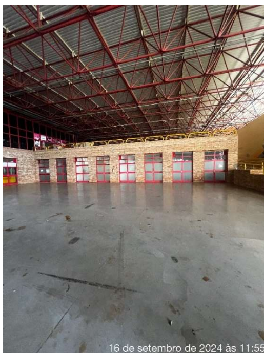
Figura 15: Pavilhão Cataratas - Acesso Salas
