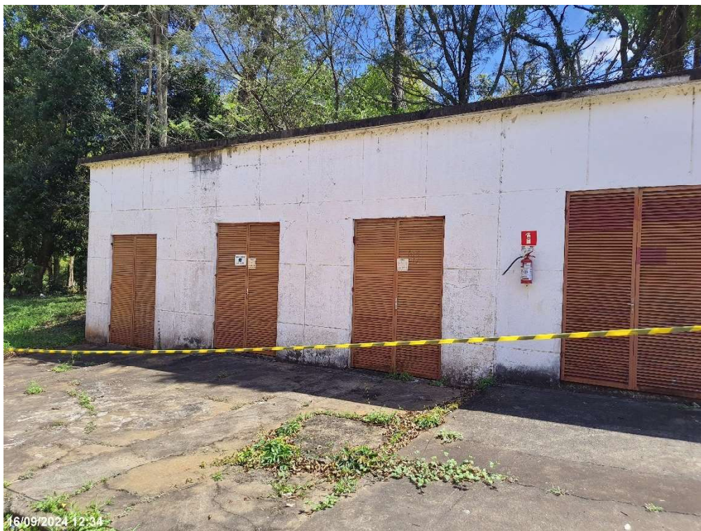
Figura 62: Edificação Anexa - Subestação
